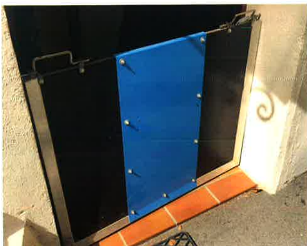
Batardeau - source Mayane
